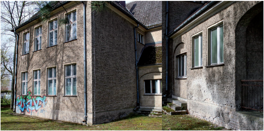
Das alte Schulgebäude „Haus 1“ in Fredersdorf Süd (siehe 2. c)
